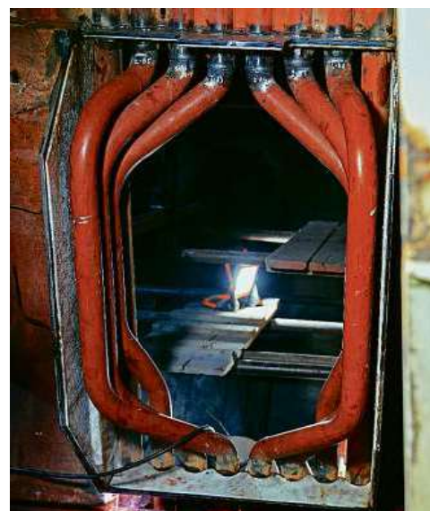
Pohled do vnitřní části kotelny kotle K6: aktuálně vybudované prostupy do kotle K6 pro novou trasu biomasy
