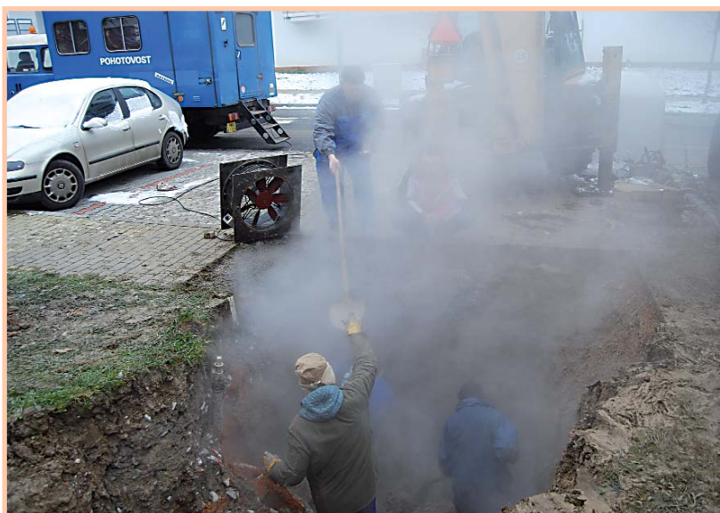
Jindřich Šíp, Petr Čurda, lopata a krumpáč ve výkopu.
