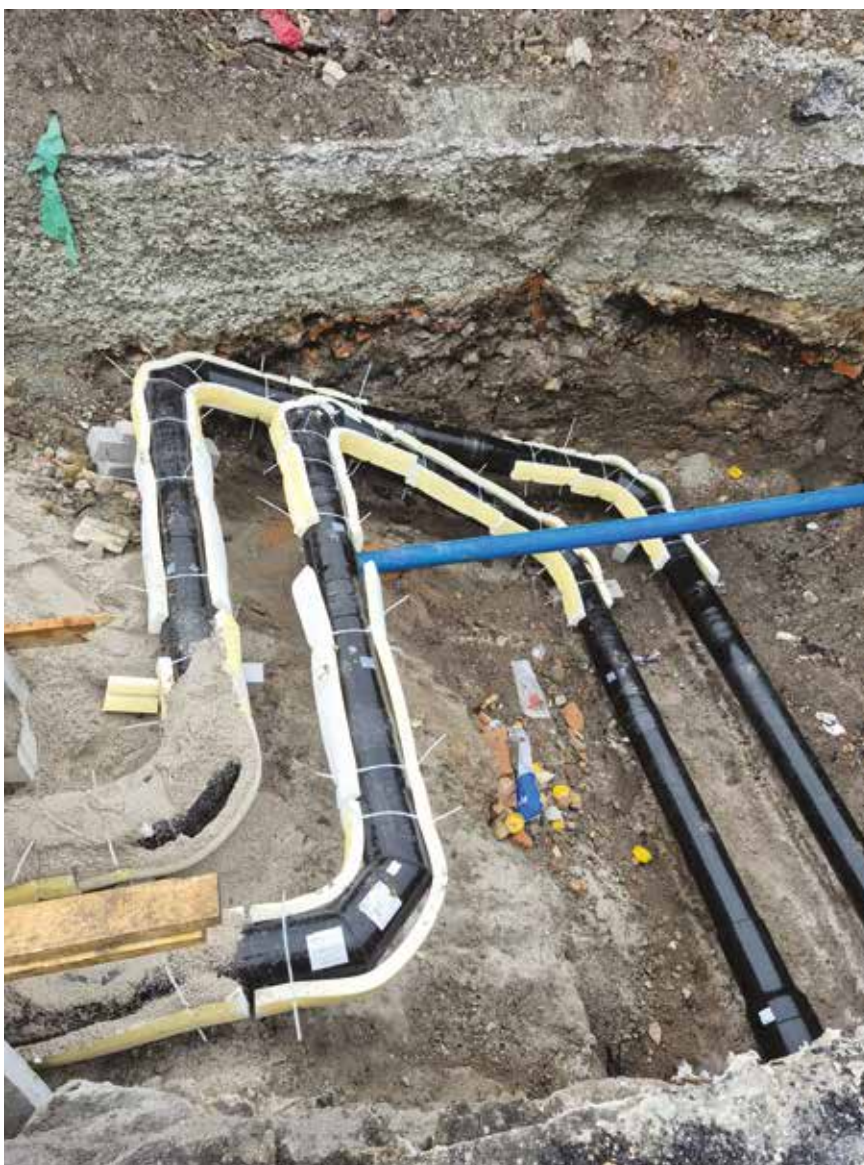
Ulice Pallova-Truhlářská: předizolované horkovodní potrubí křížící se s rozvodem vody (modrá trubka)
